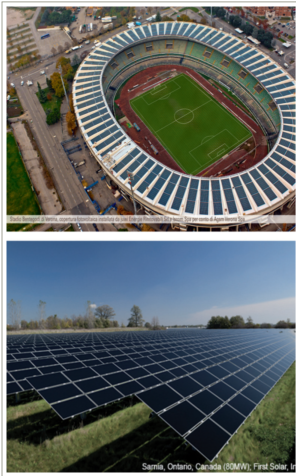
Figure 5 – Intégration de cellules photovoltaïques couches minces sur verre ; en haut dans un stade de football (à Vérone, Italie), en bas ferme solaire (en Ontario, Canada).
