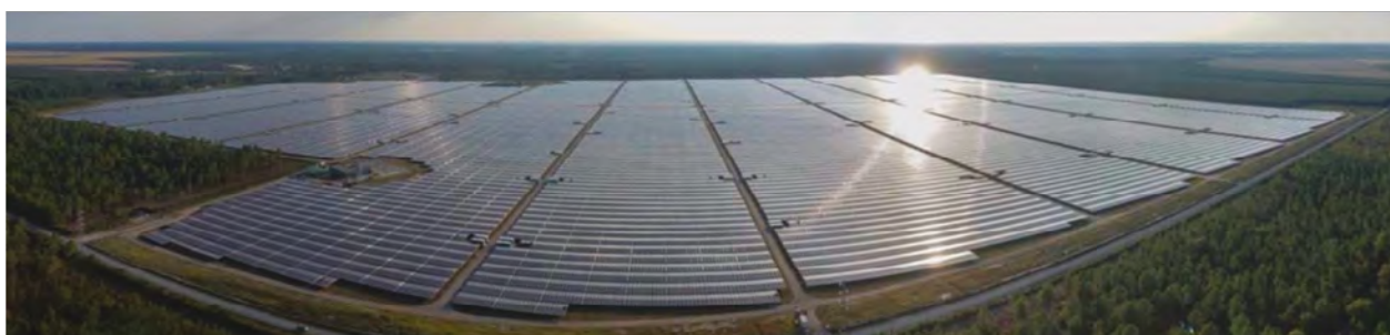
Figure 7 – Panneaux solaires d'une centrale photovoltaïque.
