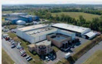
EDI – Fr 57 Dieuze (Site dédié au recyclage des batteries)
