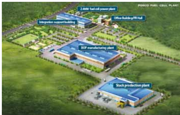
Figure 3 - La plus grande installation mondiale pour fabriquer des piles à combustible à carbonates fondus : 100 MW/an – POSCO Power en Corée du Sud.
