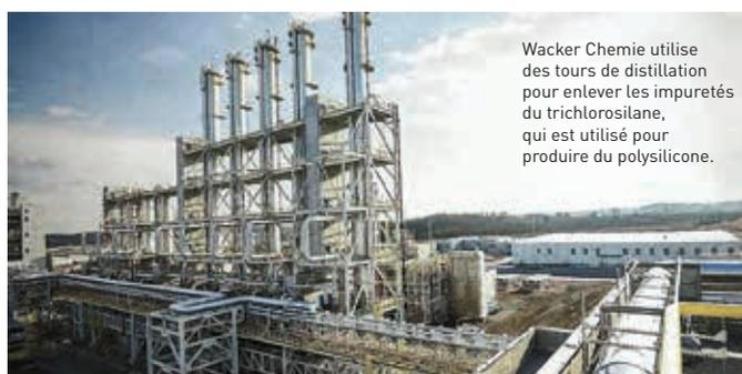
Wacker Chemie utilise des tours de distillation pour enlever les impuretés du trichlorosilane, qui est utilisé pour produire du polysilicone.
