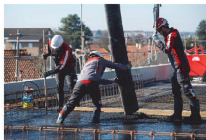
Chantier de construction du nouveau siège social de Léon Grosse (Bron)
