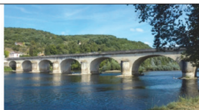
Pont de Souillac sur la Dordogne (Lot), dit Pont Louis Vicat
