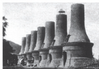
Les fours dits « biberons » de l'usine du Genevrey-de-Vif
