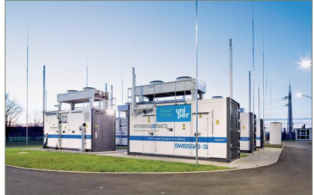
Figure 3 – L'usine de Falkenhagen en Allemagne utilise l'énergie éolienne et l'électrolyse pour transformer l'eau en dihydrogène, qui est ensuite injecté dans le système existant de transport de gaz naturel régional. Source : Courtesy of Energy Storage GmbH.
