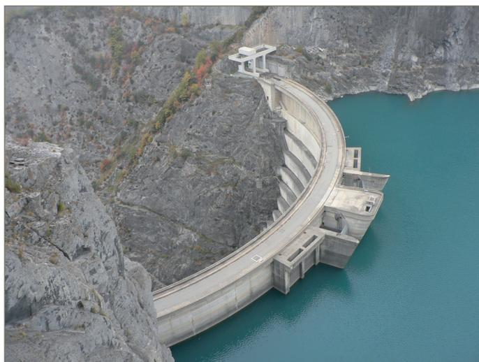
Figure 1 – Une masse d'eau stockée derrière un barrage possède une énergie potentielle. La chute de cette eau au travers d'une turbine, qui entraîne un alternateur, produit de l'énergie électrique.
