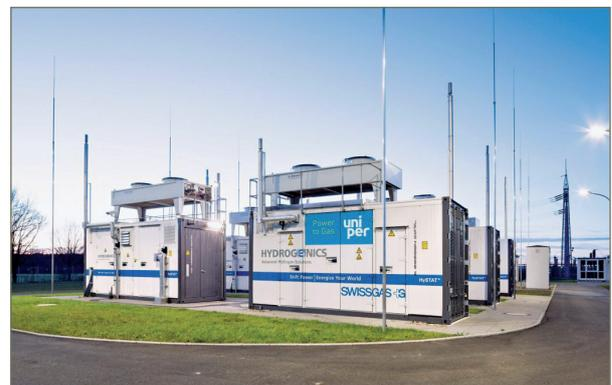
Figure 2 – L'usine de Falkenhagen en Allemagne utilise l'énergie éolienne et l'électrolyse [installation Hydrogenics] pour transformer l'eau en hydrogène. Source : Courtesy of Energy Storage GmbH.
