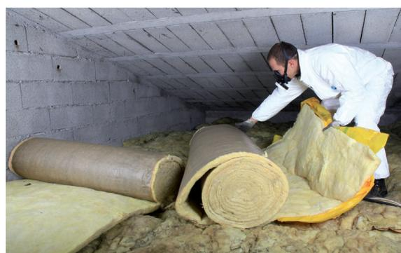
Figure 8 – La laine de verre, la laine de roche, les mousses, etc., permettent de limiter les déperditions de chaleur dans les bâtiments, que ce soit au niveau des murs, des vitrages, des combles ou des sols.
