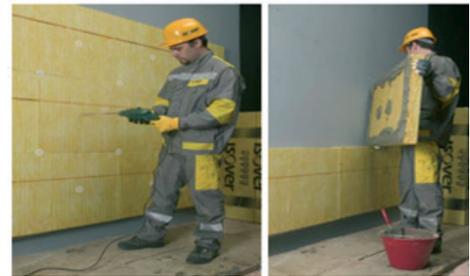
Figure 11 – Éléments constitutifs d'une Isolation Thermique par l'Extérieur (ITE) (colle, isolant, armature, renforcement, sous-enduit, enduit).
