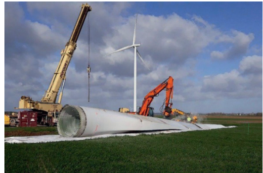
Recyclage de pales d'éoliennes sur un site en Belgique © IPM Recypale
